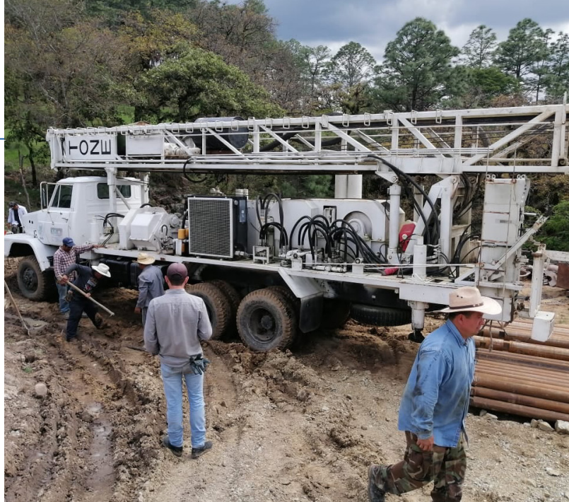
Perforación de Pozo aldea Tres Cruces / Sipacapa / San Marcos
